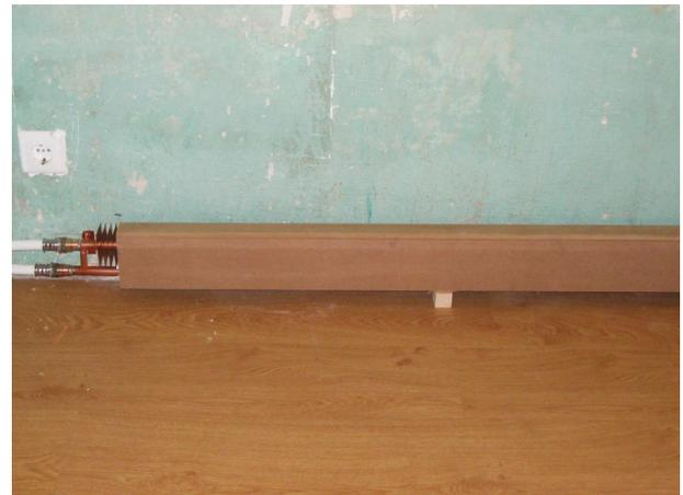
*Abbildung 4: Verblendung der Heizleisten nach Montage*
