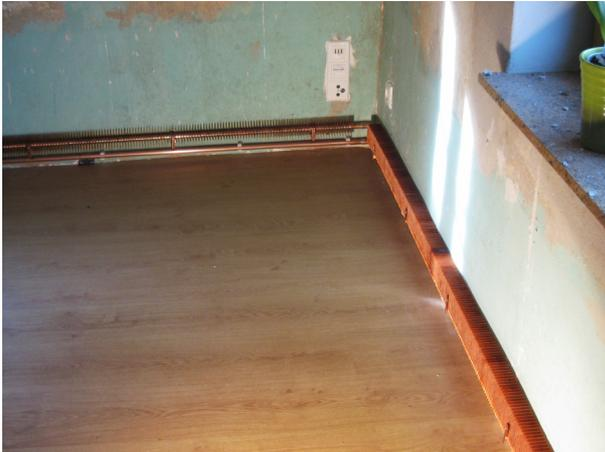
*Abbildung 3: Eckverlegung der Heizleisten im Raum*
